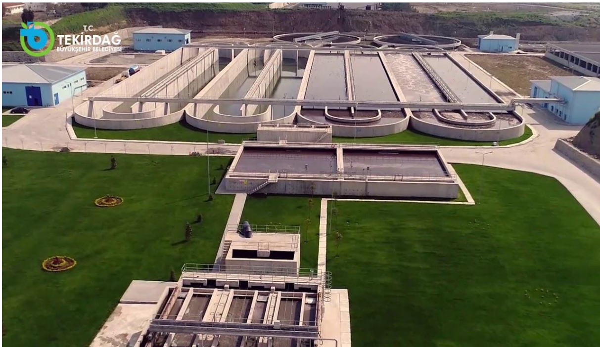
Şekil 13: Süleymanpaşa Batı Atık Su İleri Biyolojik Arıtma Tesisi
