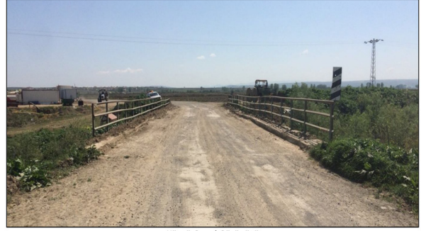
Köprü Genel Görünüşü
